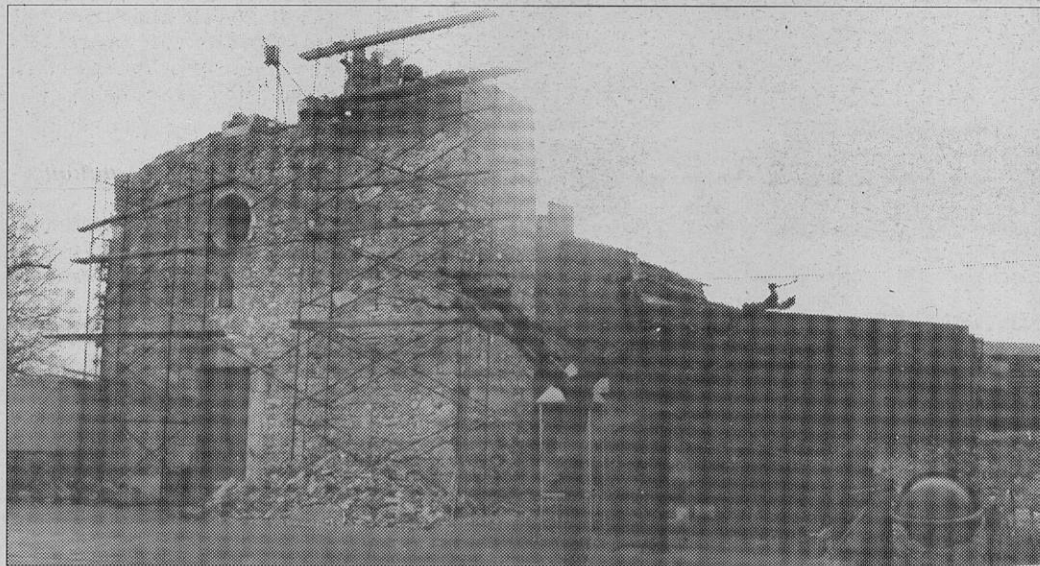
Ja s'han iniciat les obres de restauració de la façana de l'església (foto: Giró)
