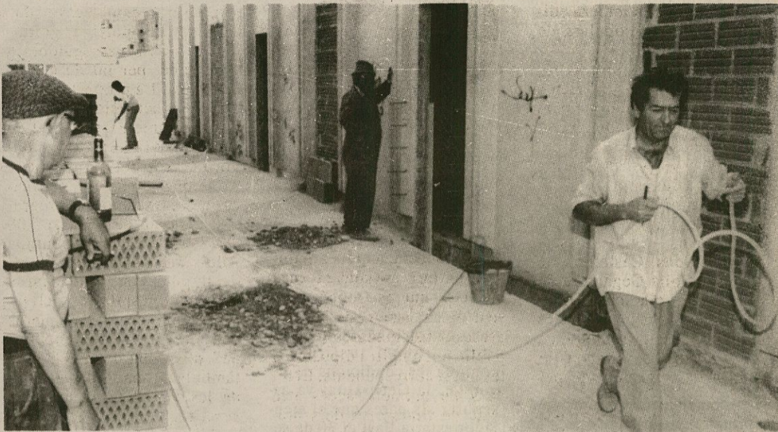
Obres a l'Escorxador Comarcal el passat mes de juny. Foto: Quim Giró.
