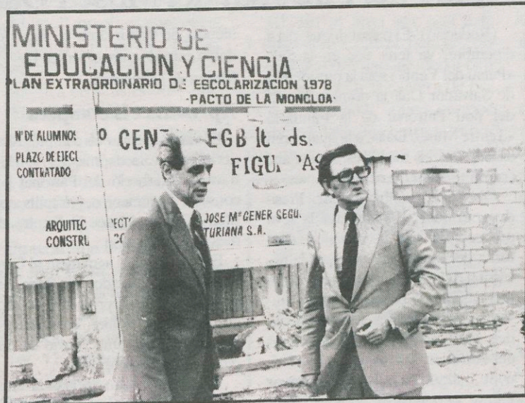
Artur Calsina i Miquel Esteba visiten l'escola en construcció
