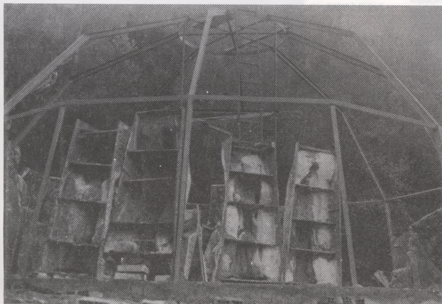
Procés de construcció, ja amb els motllos.
