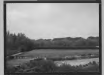
Construcció de la piscina municipal 633.590 €
