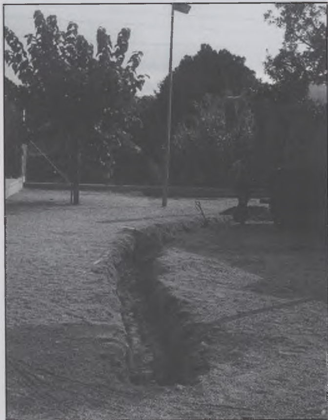
Obres per solventar els problemes de drenatge.
