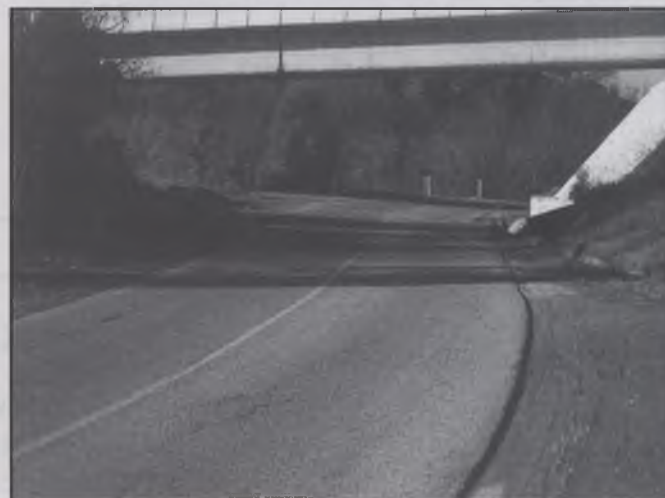
Estat actual de la C-250
