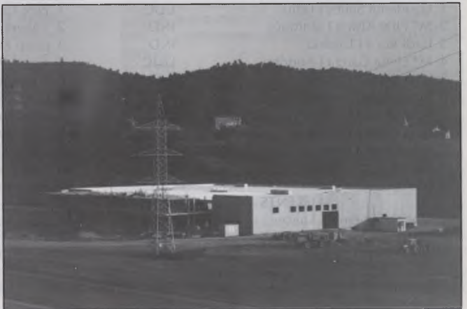
Construcció de la fàbrica de BioCentury.
