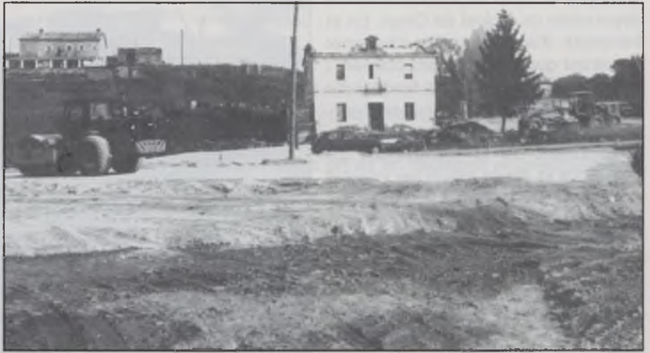
Obres de la nova cruïlla de La Creueta
