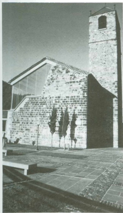
Exterior de l'església vella de Castellfollit, totalment restaurada.
