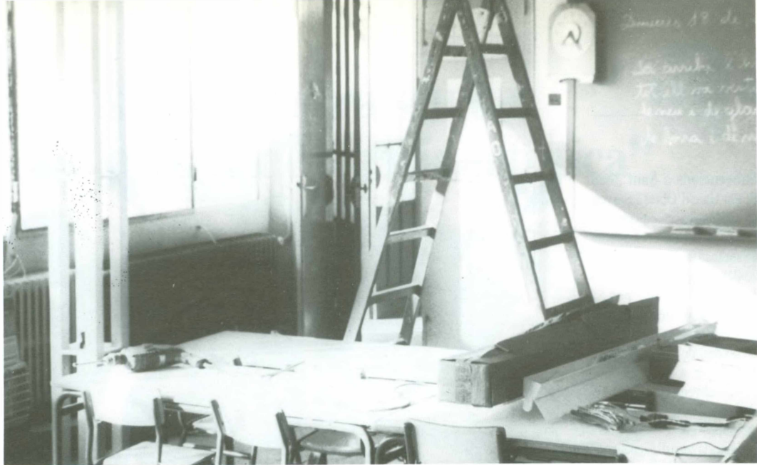
Aula del Malagrida, en obres aquests dies de feina.
