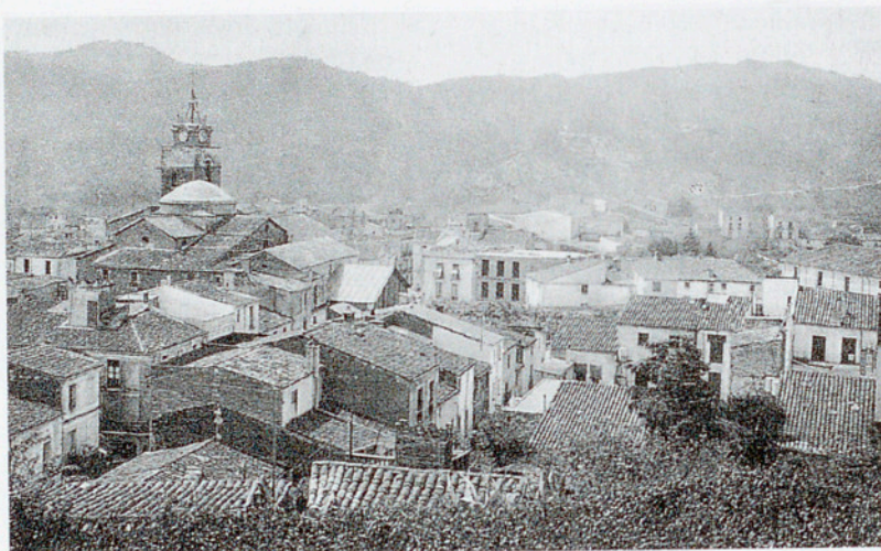
Vista de Santa Coloma, amb el campanar en primer terme.
