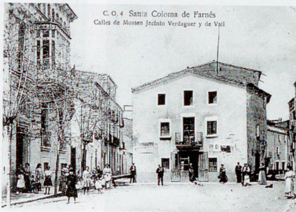
Començament del carrer Sant Sebastià l'any 1916. A l'esquerra la casa Bofill, de l'arquitecte Bassegoda, i, a la dreta, el carrer de Vall, avui Pare Rodés.
