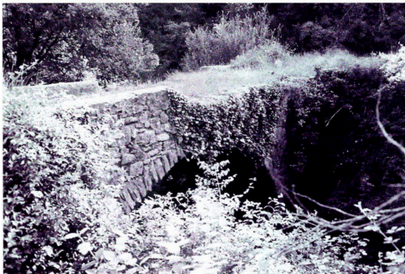
Pont de Barri o, segons alguns, Pont del Diable. És l'exemple més antic de construcció viària que es troba a les Llosses.
