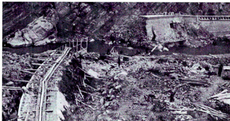
Construcció de la resclosa de la Sebastiana.
