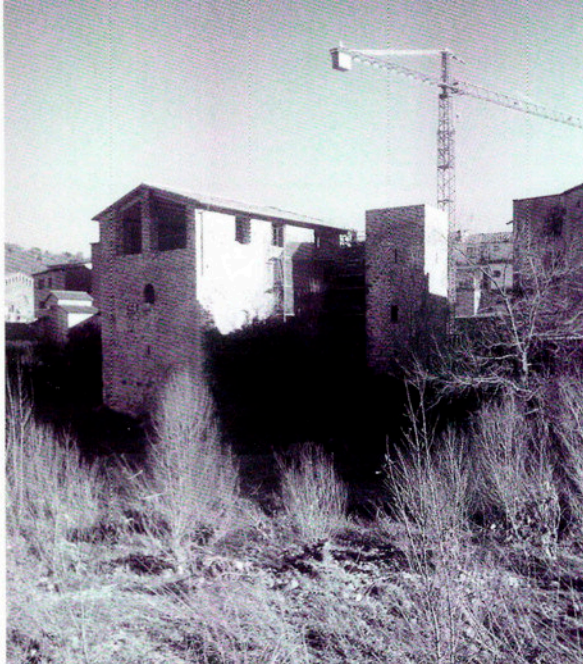
Aspecte actual de l'Estada, en fase de restauració.
