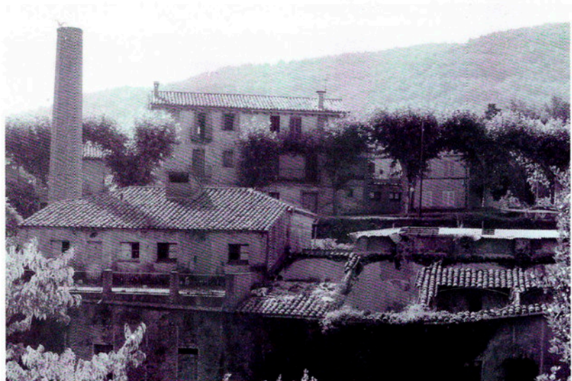
Aspecte actual de l'antiga Fàbrica Torres.
