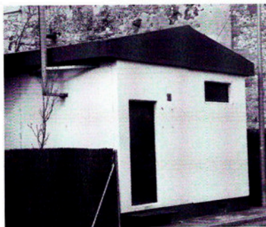
Central de Telefónica situada al carrer del Delme.
