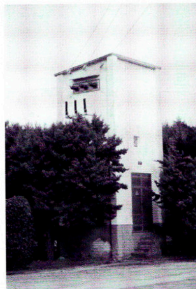
Transformador de l'Avinguda Josep Pla.
