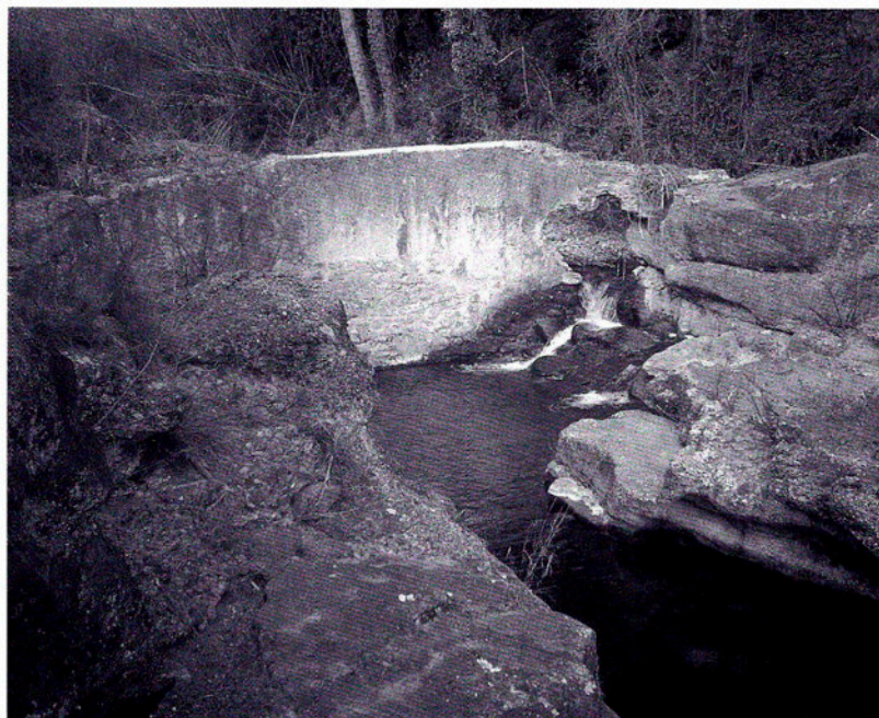
Resclosa construïda al Manol que servia per conduir l'aigua a la turbina que generava electricitat.
