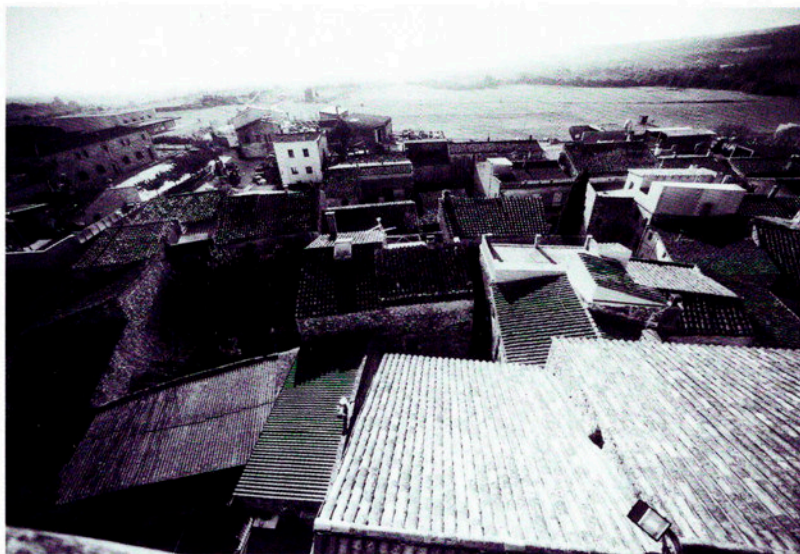
Cases de l'entorn de l'església vistes des del campanar.
