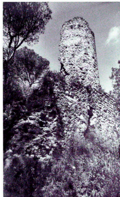
Exterior de la torre i fragment de mur.
