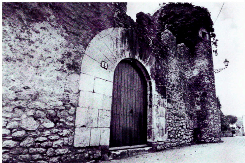
Façana de l'edifici anomenat "el Castell", fet edificar per Cipió de Vallgornera vers el 1561.
