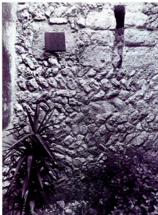
Fragment de mur del temple amb les pedres disposades en "opus spicatum".
