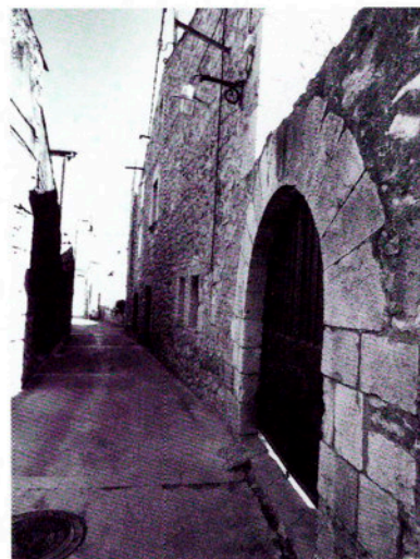
Casa amb dovelles de pedra al carrer del Bosc.
