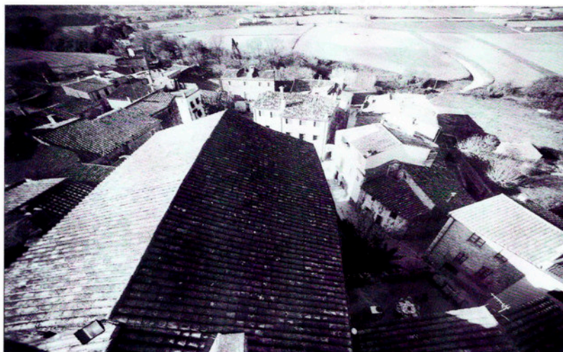
Perspectiva des del campanar amb la teulada de l'església en primer terme.
