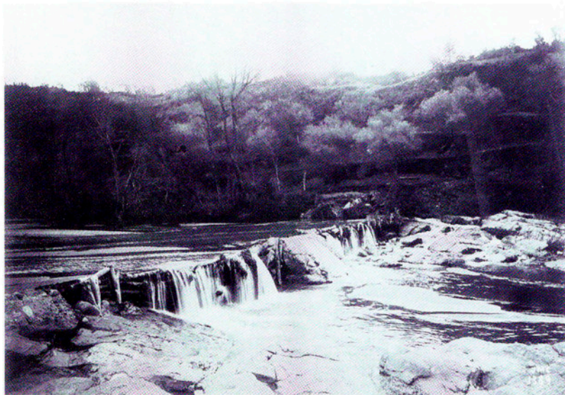
Resclosa de la Muga prop de Boadella. Les rescloses conduïen l'aigua a uns canals que anaven fins els molins per fer anar els mecanismes.
