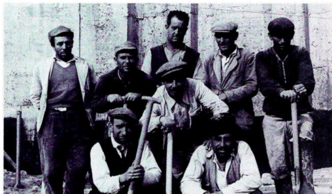
Treballadors a les obres de l'embassament de Boadella a començament dels anys 60.
