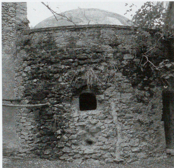
Pou de glaç del Molí, vora la Ribera de Siurana. És una mostra interessant de l'arquitectura popular, que necessitaria una restauració que li fes recuperar el seu primitiu aspecte.
