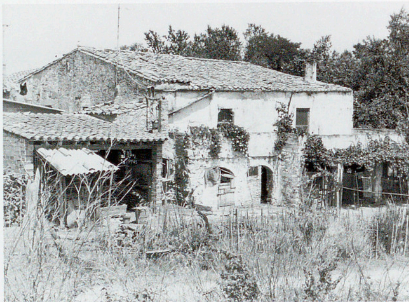
Can Jan Auberni, al començament del carrer de Baix, tenia elements arquitectònics originals del segle XVI.
