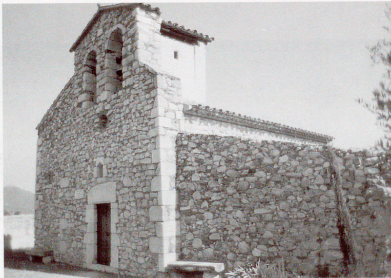
Església de Sant Llop, després de la darrera restauració de l'any 1982.
