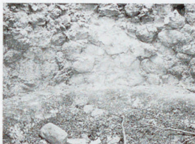
Detall de l'interior del forn de calç de Can Plana. Les parets interiors estan vitrificades a causa de l'ús continuat.
