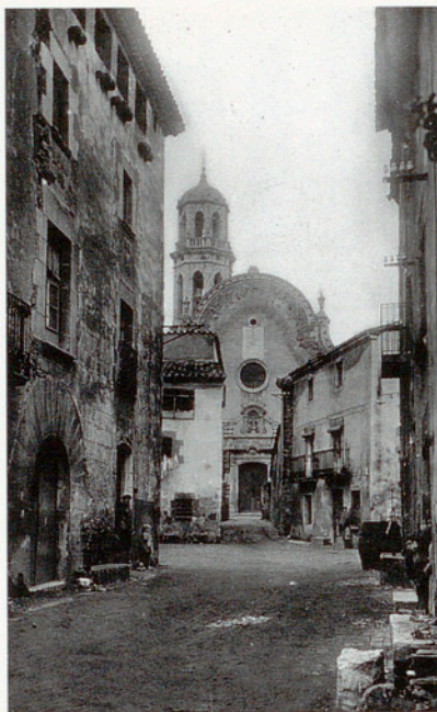
Vista del nucli antic. En primer terme can Roscada i més enrere, la casa del teixidor, enderrocada l'any 1937 amb motiu de l'ampliació de la plaça Vella.
