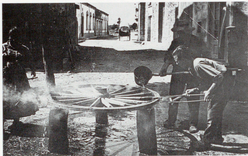
El carreter Comas i el ferrer "Miliu" ferrant una roda a la plaça Nova. Dècada dels vint.
