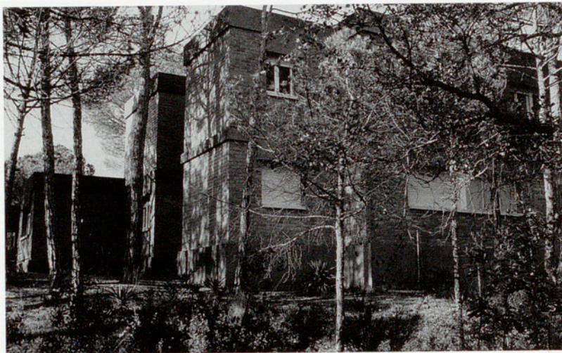
Aspecte exterior del monestir.
