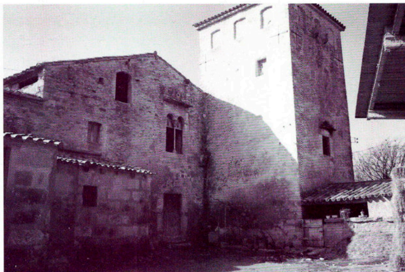
Can Bassas, antiga masoveria avui deshabitada.
