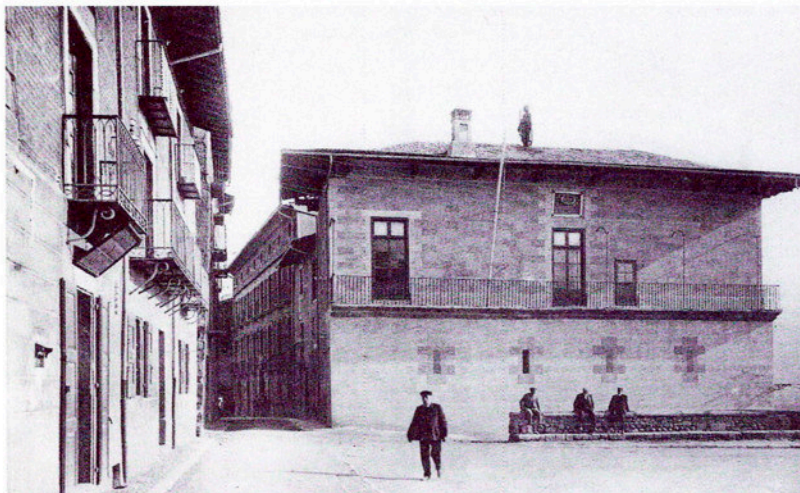
Antic edifici consular o ajuntament, cap i casal de tota la contrada.
