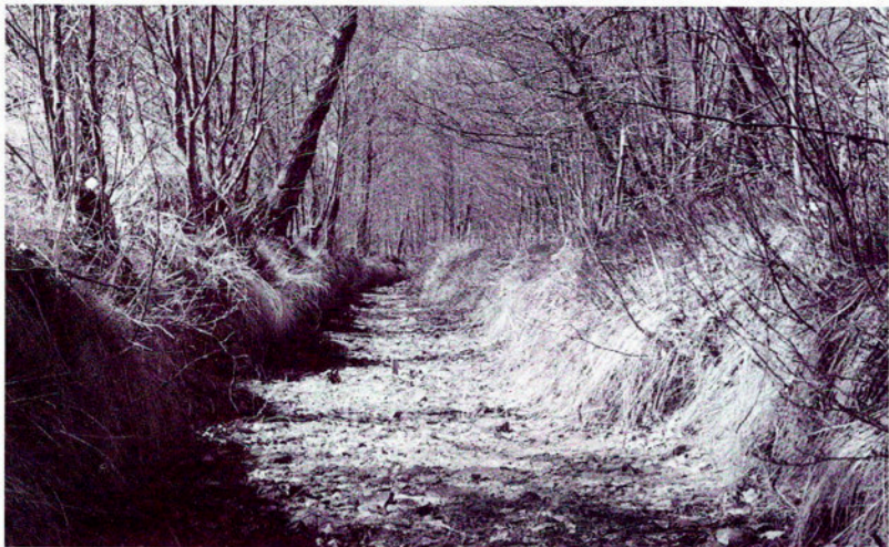
Llit de la sèquia abans de les obres de 1991-1992.
