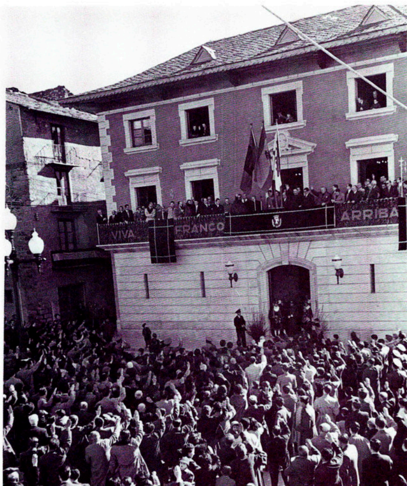
Inauguració del nou edifici consular. 12 de febrer de 1955.
