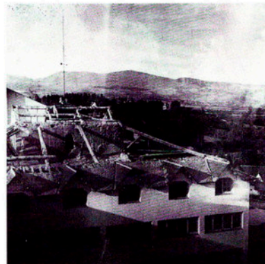
Enderrocament de l'antic edifici de l'Escola Pia.
