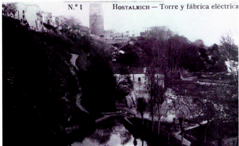
La bassa del molí que formava part de la central elèctrica.
