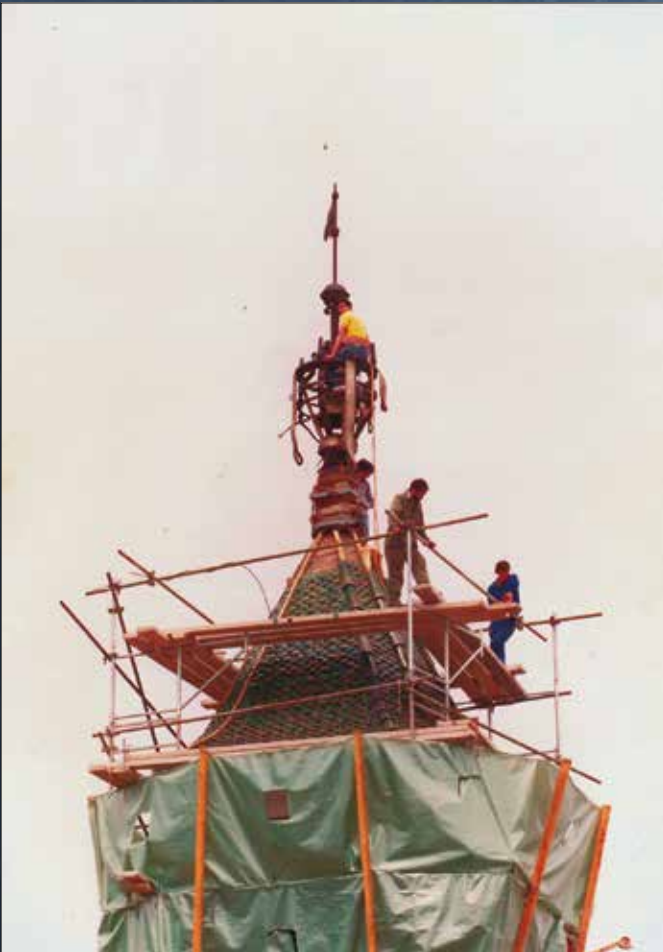
L'any 1983 paletes d'en Jaume Collbatallé restauen la punta del campanar. Renoven la teulada de ceràmica, canvien les campanes i hi restauen la creu al punt més alt. Hi treballen Ll. Serradesanferm, M. Bayés i A.Ramon. Foto cedida per Lluís Serradesanferm
