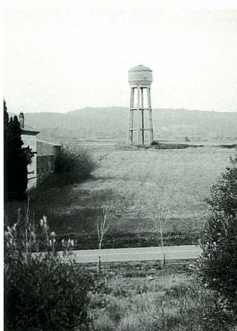
El dipòsit d'aigua elevat sobre quatre columnes, construït entre el 1968 i el 1969 a la part més alta del poble.
