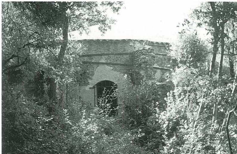
La part superior del pou del glaç de Palau Borrell, amb l'entrada principal. Més amunt, a l'esquerra, una petita obertura també permetia accedir al seu interior quan era ple fins dalt.
