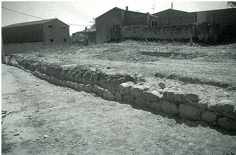
Basament del mur que tancava la Pabordia per l'extrem nord, límit del primitiu recinte medieval de Viladamat.
