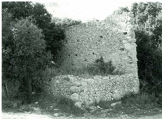
L'alt mur que deixava a recés el gran safareig del pou del glaç de Palau Borrell i evitava que el sol fongués el gel abans d'hora.
