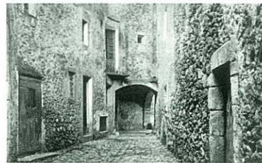
La Volta del Carrer Espígol també va ser enderrocada.
