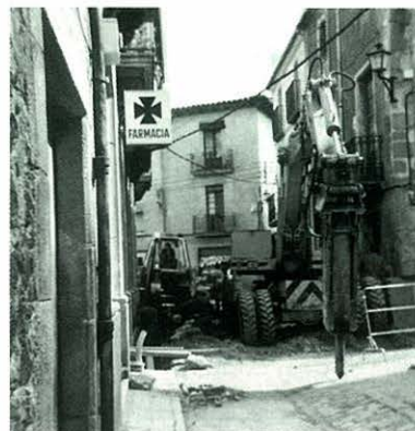
La construcció dels col·lectors als anys 1980 fou un pas definitiu en el sanejament del poble.
