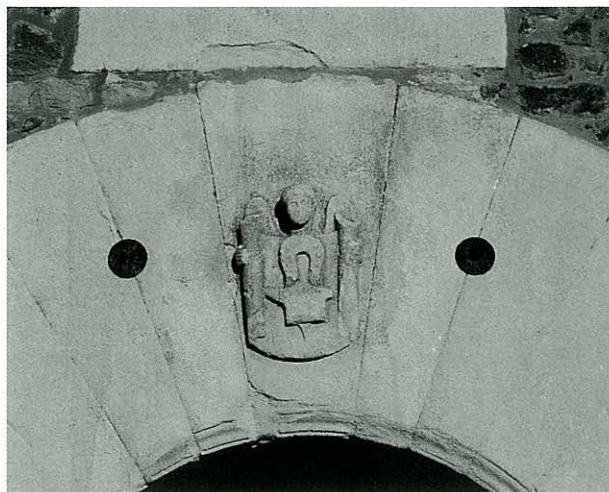
Carreters i ferrers (a la foto, Can Mau) s'establiren en el Camí Ral.
