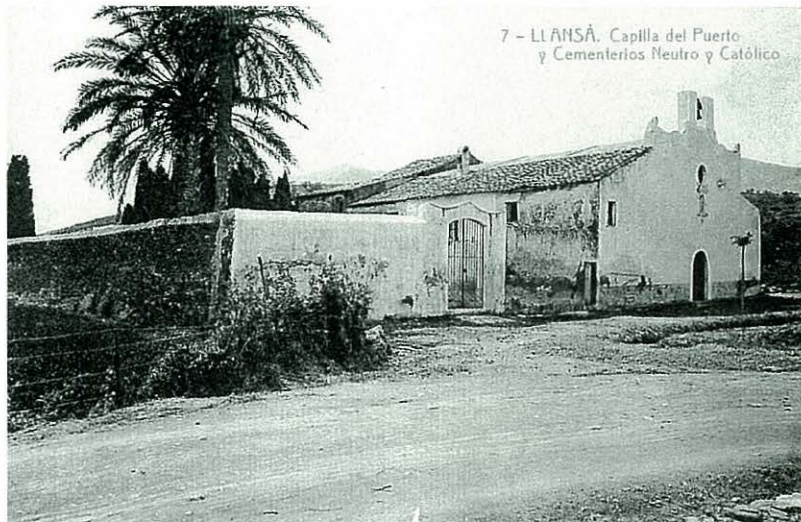
L'exterior de la Capella al costat del cementiri.
