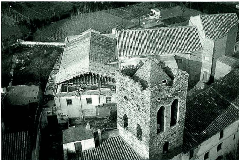
Inici de les obres d'enderrocament.
