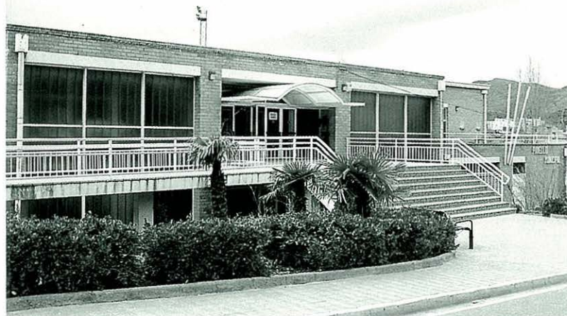
Façana principal del pavelló i porta d'accés.
