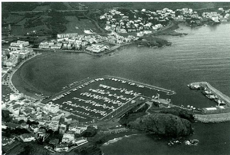
El port construït i ja en ple servei.
