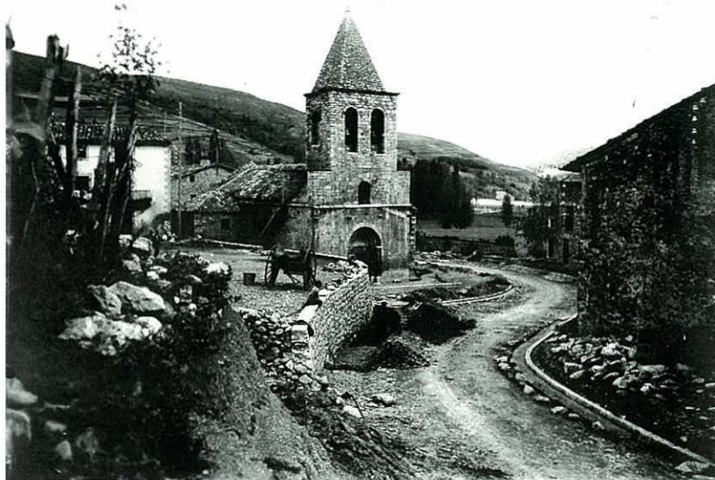
Construcció de la carretera Camprodon-Setcases.
