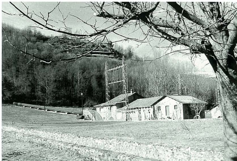
Central hidroelèctrica Bassols.
