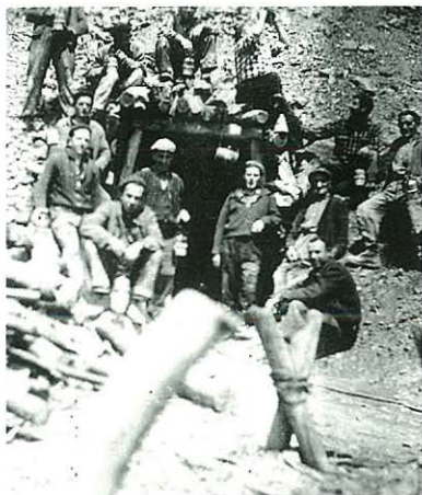
Minaires a la boca de la mina de sabonet de Fraussa.
