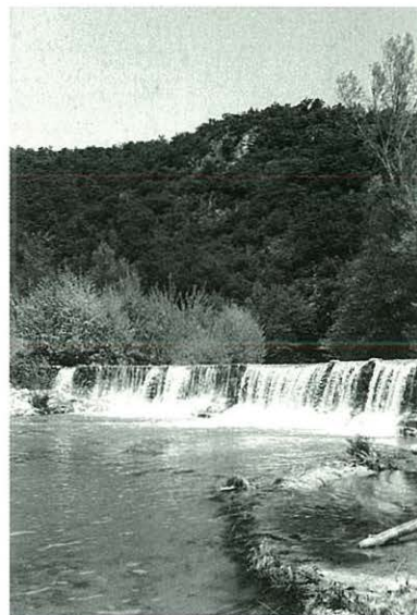
L'Arnera recull totes les aigües de la vall de Maçanet. A la foto, la resclosa de la central d'en Grida.
