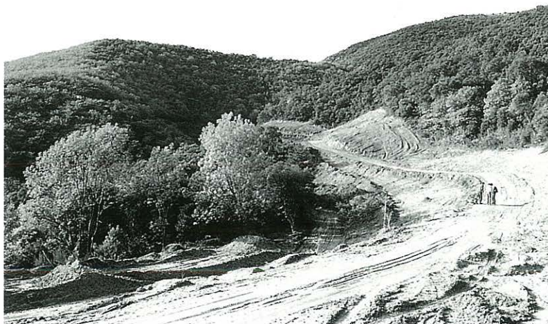
Esplanació de la carretera al pla d'en Parés, l'octubre de 1991.
