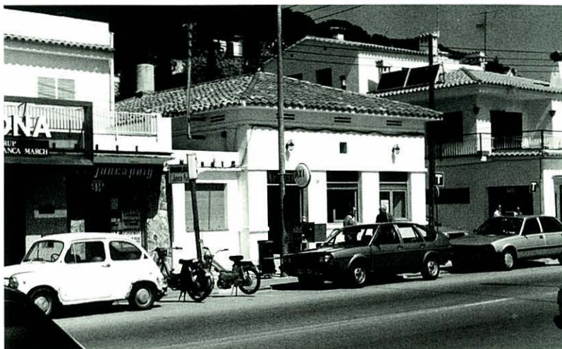
Al vell local de El Porvenir Fanalense s'instal·là la Central Nacional Sindicalista i la Hermandad de Labradores y Ganaderos.
