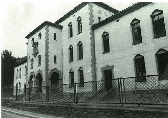
Edifici del col·legi públic Mare de Déu de Núria, únic centre d'ensenyament que avui perviu.
