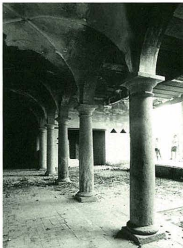
Fragment del claustre conventual que actualment resta dempeus. Es finalitzà al s. XVII. Sobre columnes cilíndriques de gust toscà reposen set arcades de mig punt.
