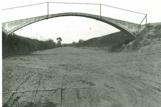
Aspecte del llit de la riera quan s'acabaven les obres de 1958. La petita passarel·la va ser enderrocada posteriorment.
