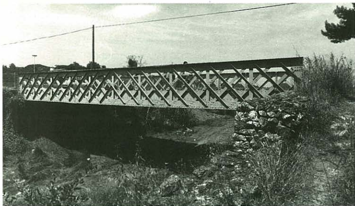
El "pont de l'Eiffel" va ser instal·lat sobre l'Aubi l'any 1968 i es va inaugurar el dia de la Festa Major de 1969. La seva construcció data de 1878 i provenia de Girona: "el pont del rellotge". Va ser comprat pels promotors de la urbanització Paratge Balitrà per facilitar les comunicacions entre Palamós i aquell sector.
