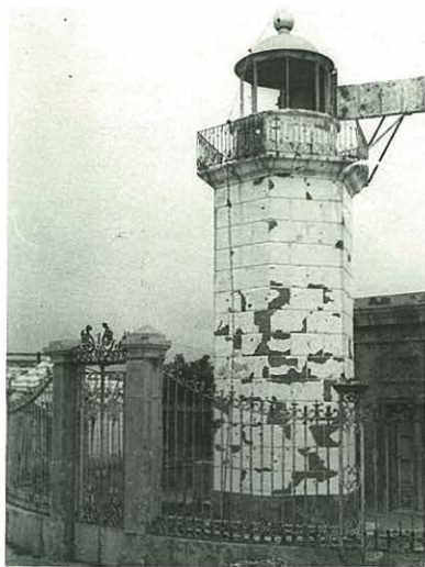
La torre del far resistí l'embat, però el conjunt quedà malmès per la metralla i s'inutilitzà el semàfor.
