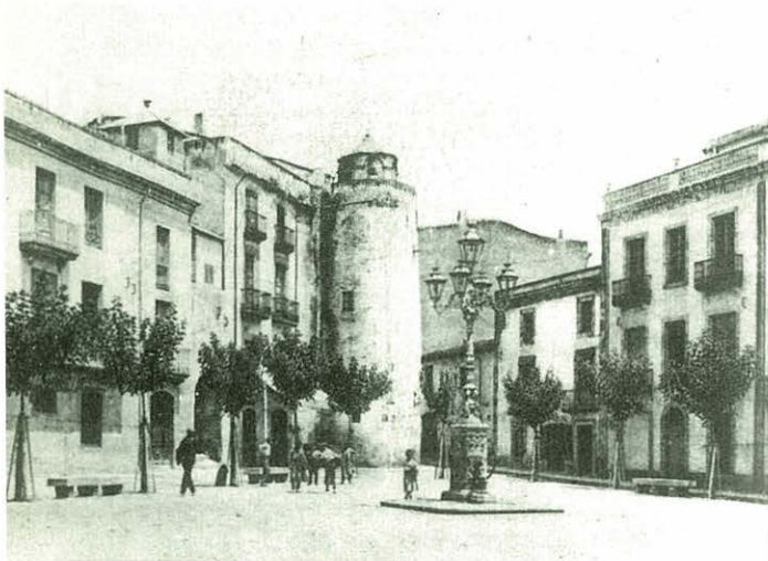
La torre d'en Moragues formà part de la muralla i fou enderrocada l'any 1908.
