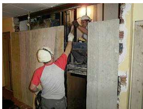
Operaris treballen en la substitució d'un dels ascensors. ddg
