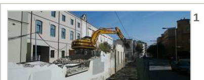
Foto d'arxiu en què es mostra un enderrocament durant els inicis del procés de remodelació de l'antiga fàbrica Coma Cros de Salt. Foto: MANEL LLADÓ.
