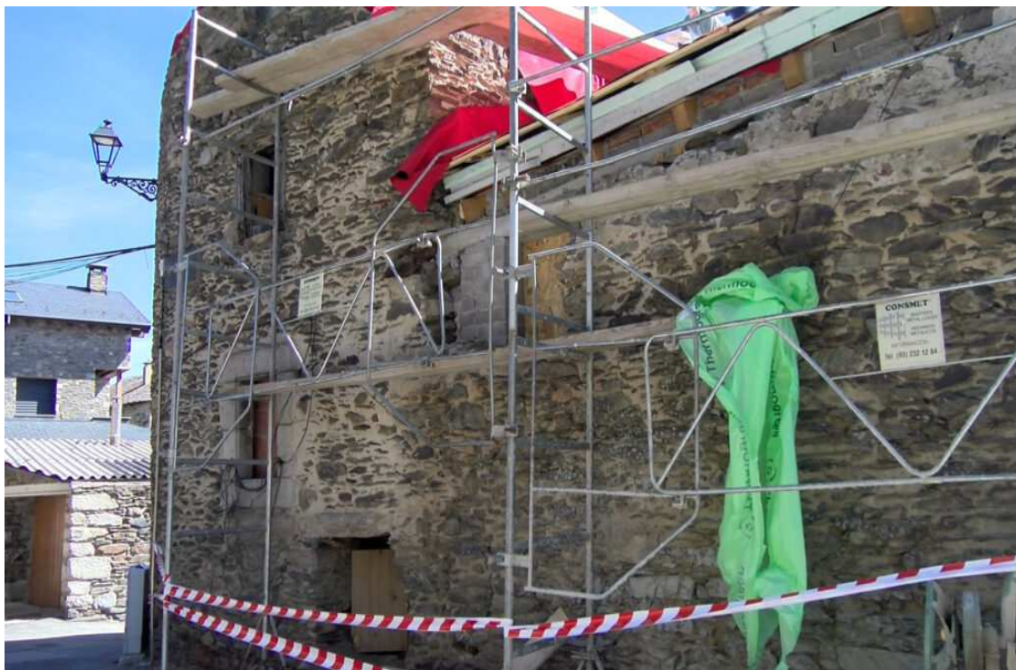
Obres a Cal Forner Vell de Guils de Cerdanya / M.F.C.
