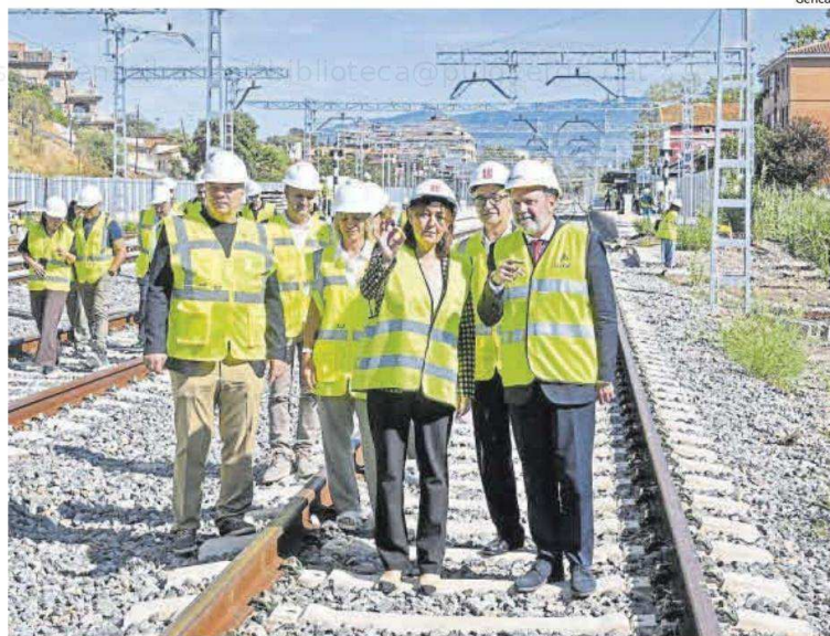
La conseller Sílvia Paneque en la visita d'aquest dijous a les obres de l'R3
