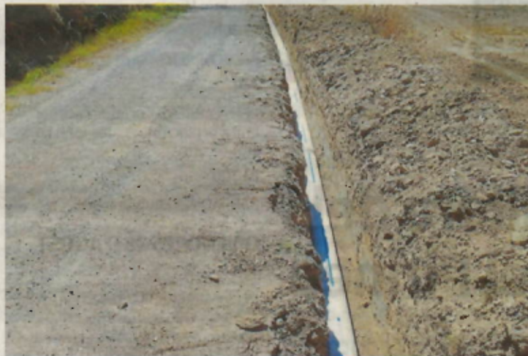
Les obres de la nova canonada.
