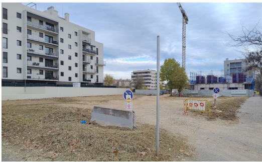
El solar del carrer de les Agudes on es construirà el nou habitatge ACN.
