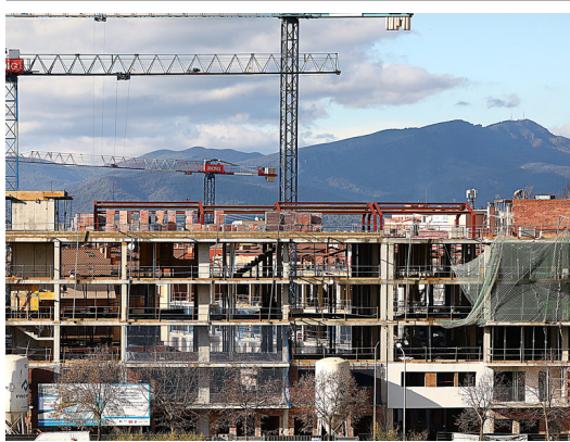
Pisos en construcció, ahir a la zona de Girona MANEL LLADÓ.
