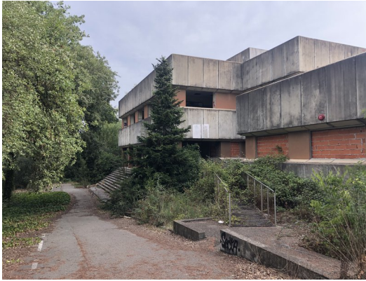
Edifici de la Generalitat abandonat EPA.
