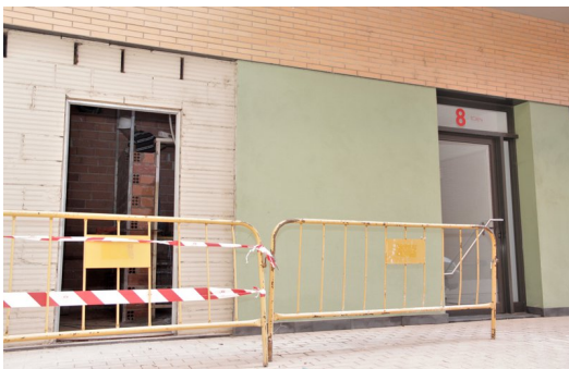
Obres d'adequació de la nova seu de l'Espai LGTBI de Girona AJUNTAMENT DE GIRONA.
