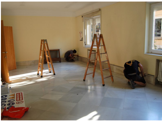
El CAP Santa Clara de Girona ha començat aquesta setmana les obres d'ampliació CEDIDA.
