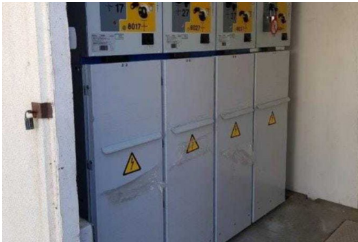
L'operativa s'ha completat amb la reforma tecnològica d'un centre de transformació. ARXIU.
