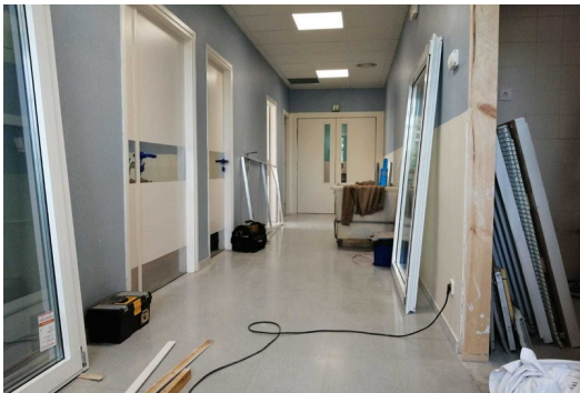
Espai que estan ja en obres, en l'Hospital de Figueres. FUNDACIÓ SALUT EMPORDÀ.
