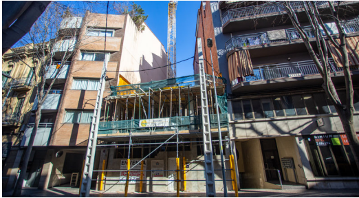
La construcció d'uns pisos a Girona, en una imatge d'arxiu QUIM PUIG.
