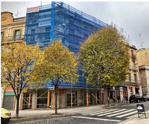
Façana en rehabilitació, a Figueres AJ. FIGUERES.
