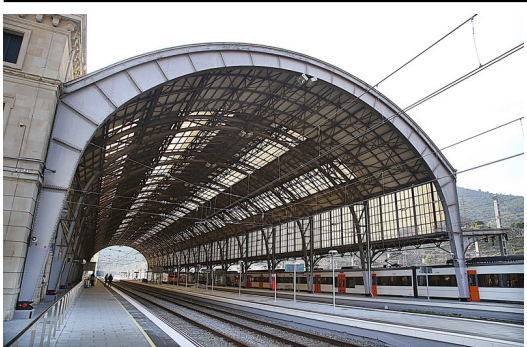
L'estació ferroviària de Portbou s'integrarà a la nova xarxa de senyalització i control M. LLADÓ.
