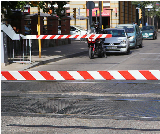
Un dels passos a nivell que hi ha a la capital empordanesa i que se suprimiran MANEL LLADÓ.
