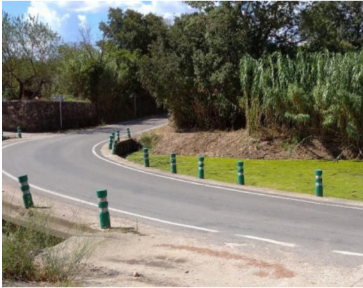
El passallís sobre el Manol que es vol eliminar amb el condicionament de la carretera CEDIDA PER LA DDG.
