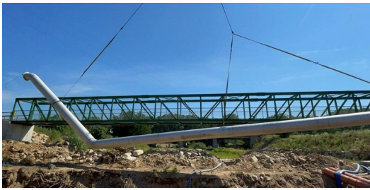
El tram de canonada que s'ha substituït al pont de la riera d'Osor entre Anglès i la Celler de Ter AJ. DE GIRONA.
